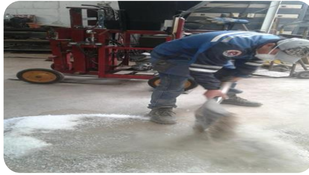
Figura 1. Proceso de mezclado de los materiales
