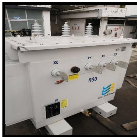
Figura 12. Adquisición del transformador de 500 kVA.
