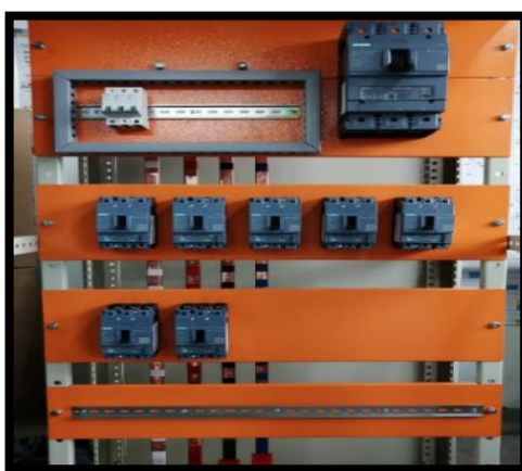
Figura 13. Montaje de disyuntores en el nuevo tablero de distribución.
